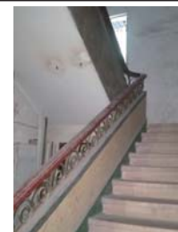
水磨石楼梯、铸铁花扶手
