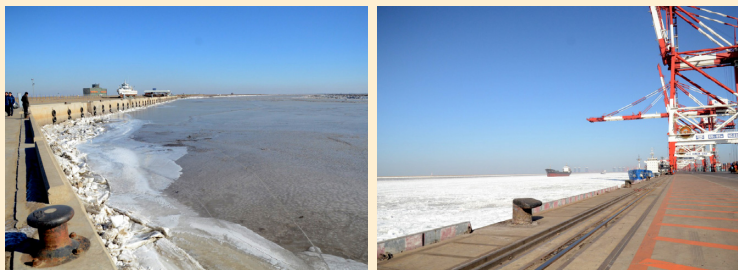
2016年1月，辽宁沿海地区海冰冰情发展迅速，渔港港池全部被冰封，部分海冰冰厚20~30厘米。
