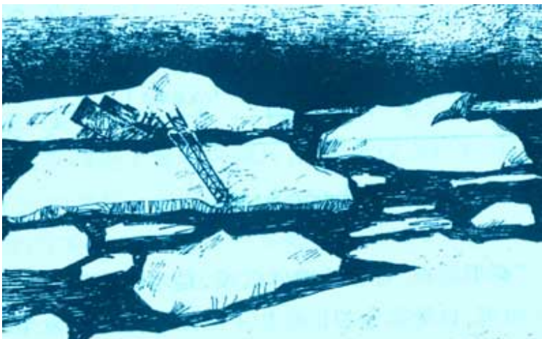
1969年渤海特大冰封期间，流冰摧毁“海二井”石油平台
