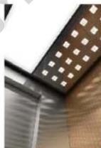
图注：轿厢壁采用发纹蚀刻镀钛不锈钢，出入口上板采用发纹不锈钢，轿门采用发纹不锈钢，前壁采用发纹不锈钢。
