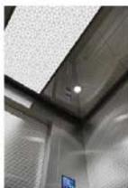
图注：轿厢壁采用发纹蚀刻不锈钢，出入口上板采用镜面不锈钢，轿门采用发纹蚀刻不锈钢，前壁采用镜面不锈钢。
