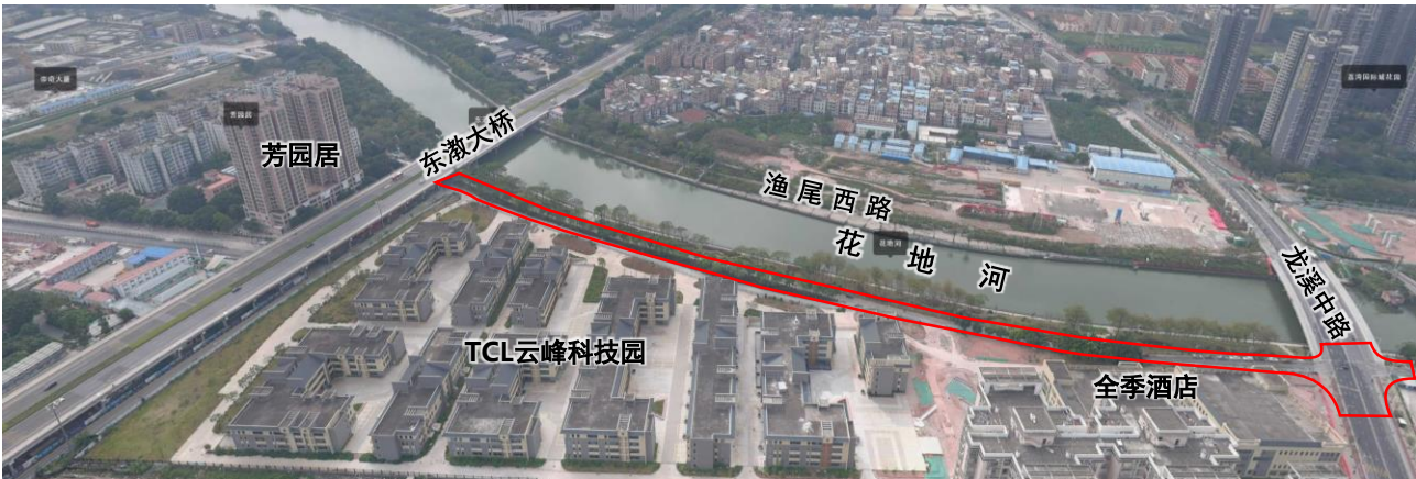
龙溪中路-东激大桥段建设现状图
